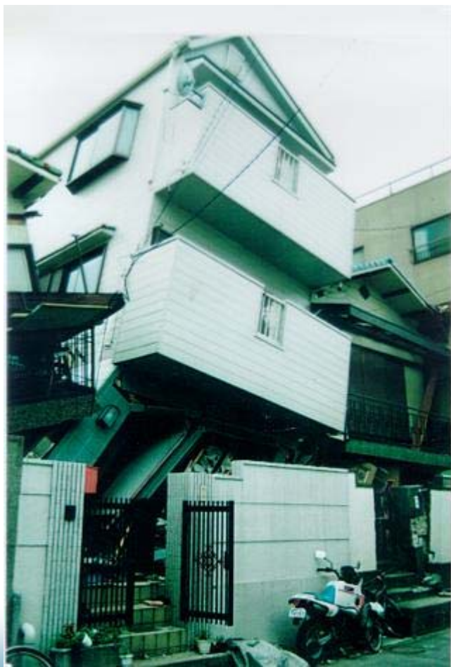
狭小間口の3階建木造住宅 (1階開口・HD金物なし)
