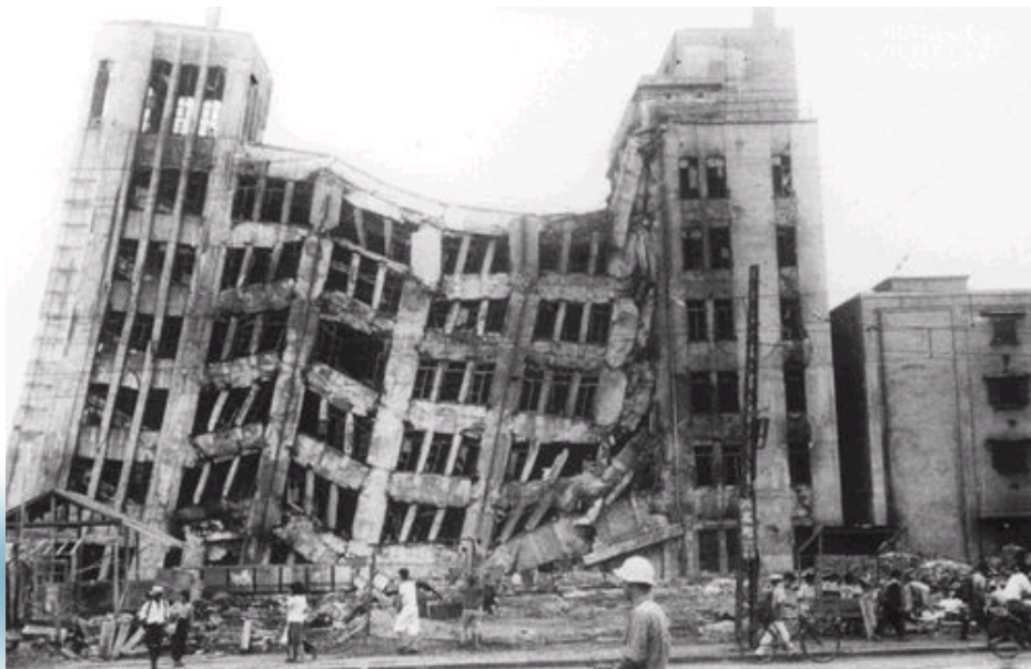
1948年福井地震による大和デパートの倒壊(活断層による都市直下地震)
