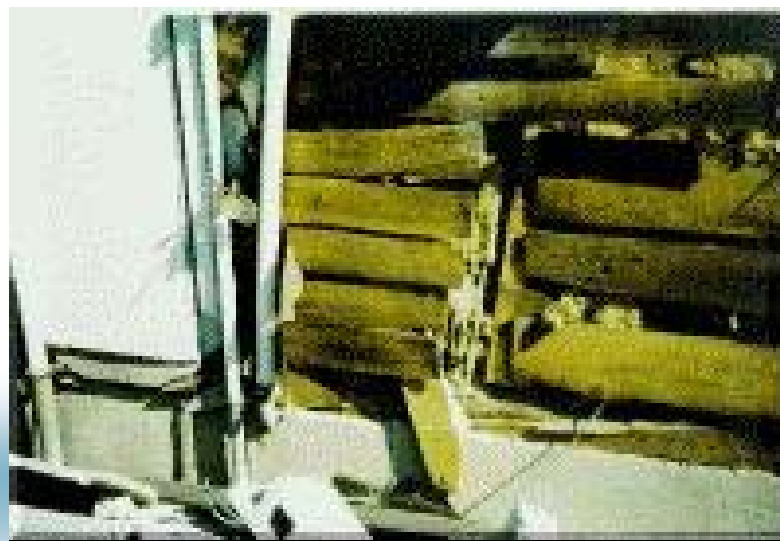
筋かいの引きぬけ・踏み外し
