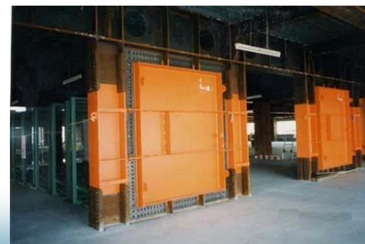
制震補強の例
