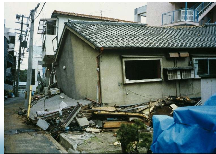
1階の耐震性が不足して倒壊した建物
