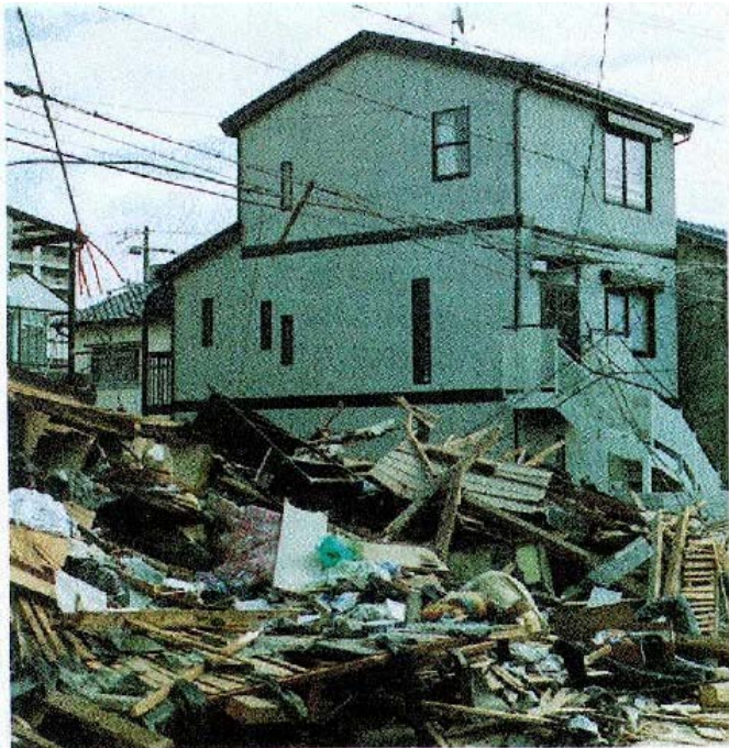
(阪神大震災全記録、毎日ムックより)
