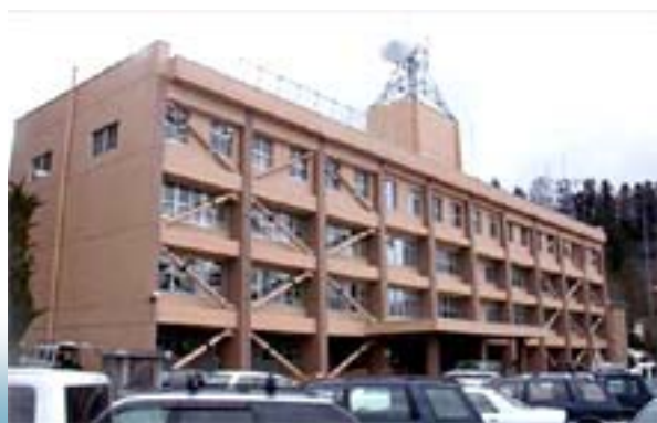
耐震補強の例
