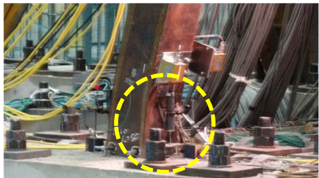
1 階柱脚の局部座屈（四角い柱がへこんでいる）
