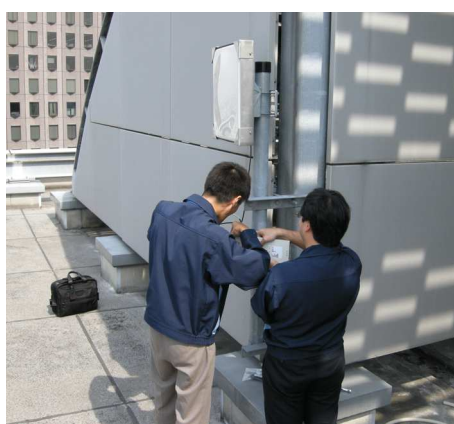
図 2-18a 新宿校舎屋上への 5G 帯 FWA の設置の様子
