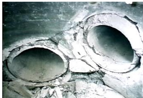
下水道管のマンホール内側への 突出し (①阪神・淡路大震災)
