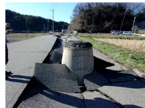
マンホールの浮上、道路 陥没 (⑥能登半島地震)
