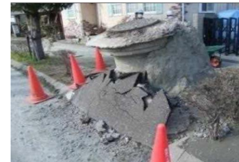
液状化によるマンホールの 浮上 (⑤東日本大震災)
