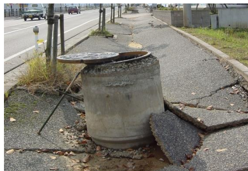
マンホールの浮上 (③新潟県中越地震)
