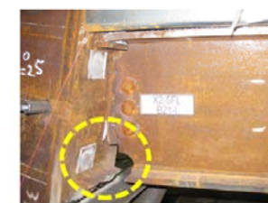
梁端下フランジの破断
