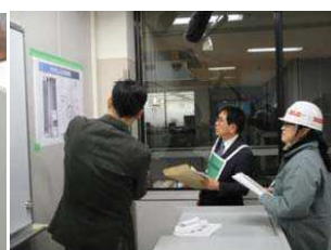
施設管理者と建築専門家に建物安全確認(4階)
