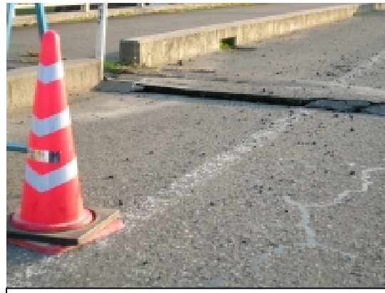
写真 38 車道の亀裂 2
