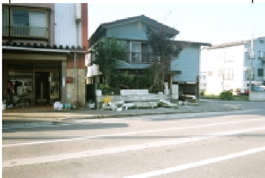
写真 24 住宅への被害は少なかった が塀や石垣の損傷が見られた。
