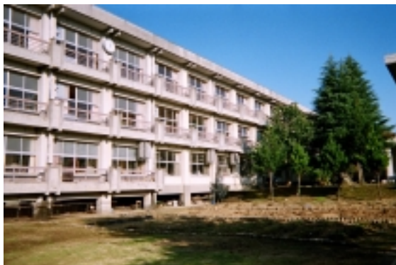
写真 13 中庭より南側校舎を見る
