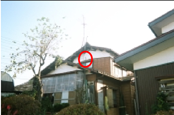
写真9 漆喰の剥落
