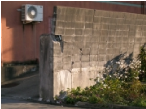
写真 24 住宅への被害は少なかった が塀や石垣の損傷が見られた。
