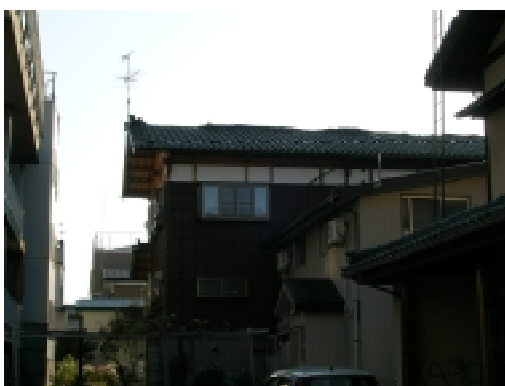
写真 28 屋根瓦に損傷を受けた住宅
