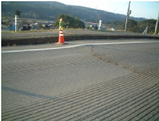
写真 37 車道の亀裂
