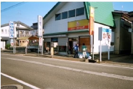
写真11 ショーウィンドーの割れた商店
