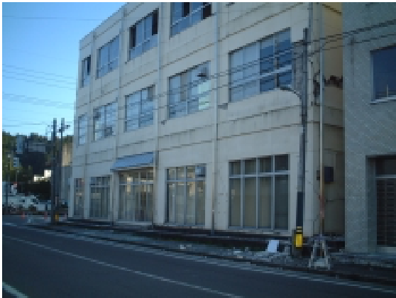
写真 32 市役所前の交差点に建つビル 十日町市市街地で最も大きな損傷を受けていた。
