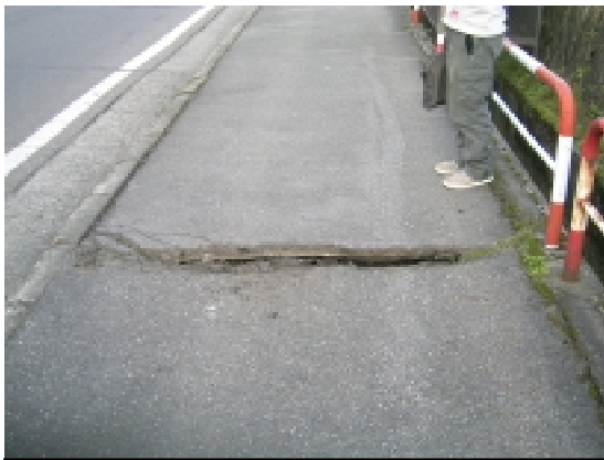
写真 35 歩道の陥没
