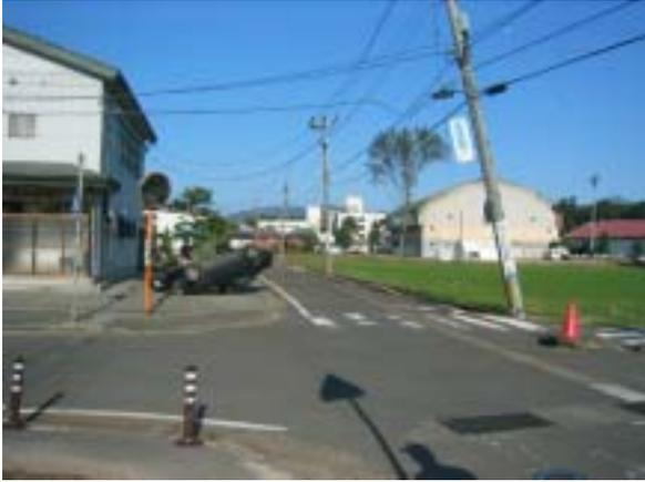
写真 7 右奥が K-Net の設置位置。手前の車はマンホールにぶつかり転倒？このように下水管道部分の路面が沈下し電柱の傾斜がいたるところに見られる。
