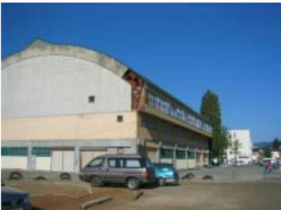
写真5 妻面の外壁の剥落
