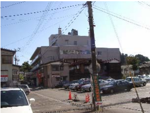
写真-12 水仙の家(免震建物)の全景(積層ゴム+すべり支承タイプ)。事務長にお伺いしたら揺れたけど特に問題はなかったとのこと。ただし、電気、ガス、水道は周りが全部だめなので、やはりだめ。多少の蓄電分のみだったとのこと。1Fは本館(この施設は前の写真の小千谷総合病院の分館)からの避難者でいっぱいだった。
