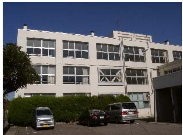
写真-4 与板高校(与板町、K プレースにて補強済 み、被害なし)
