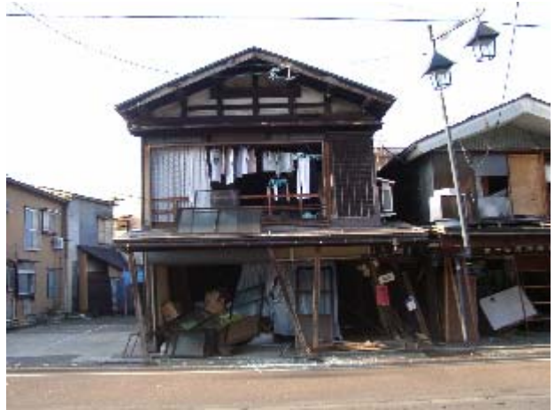
写真-25 被災後立入り禁止となる木造住宅(小千谷市本町、建物の傾斜が立入り禁止の理由)
