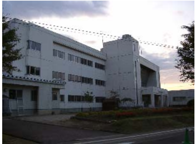
写真-36 千田小学校の校舎全景(小千谷市千谷) 軽微な被害、被災前に発生しているひび割れが多数あり
