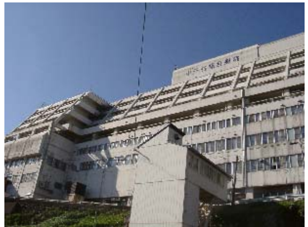
写真-8 小千谷総合病院(RC造約7階)の全景(南側、3F以上でスプリンクラー故障水浸しとのことで使用できないそうだ。)
