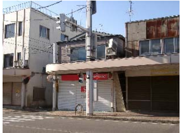
写真-19 291 号の商店街の室外機の倒れ
