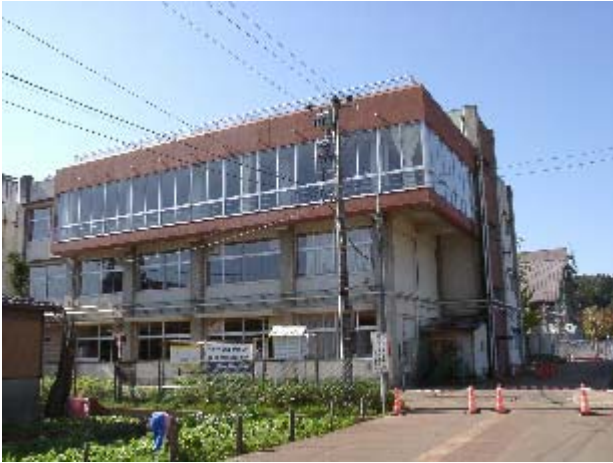
写真-5 与板小学校(与板町、補強工事中、被害なし)
