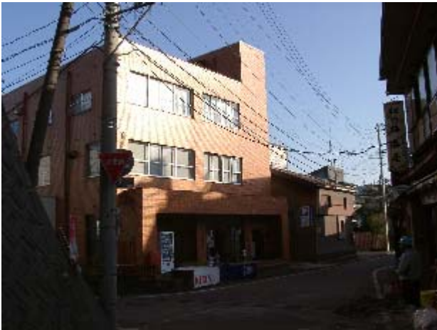
写真-23 自動販売機が道路の真ん中まで転倒し、その後手前に戻した(小千谷市本町)
