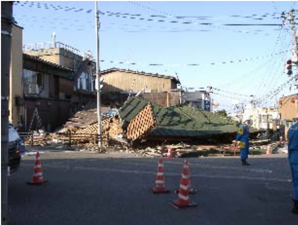
写真-22 木造住宅の崩壊(小千谷市本町)
