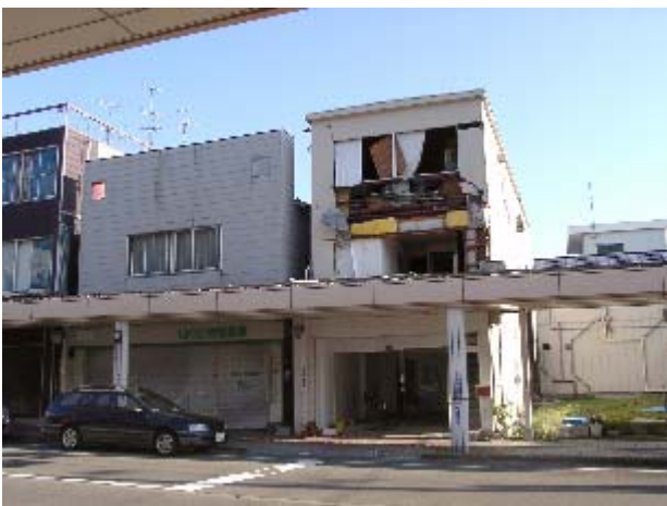
写真-18 291 号の商店街の鉄骨造の店舗兼住宅の外壁剥落状況(小千谷市本町の商店街)
