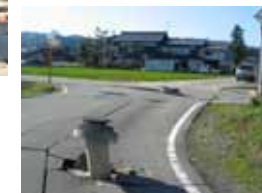
桜町周辺，小千谷市総合体育館近く 倒壊建物の前面道路のマンホールの浮き出し
