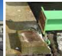
桜町周辺，小千谷市総合体育館近く 屋根はRC防水，各階で主構造と非接合 柱脚部分(アンカーボルト破断)
