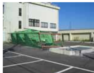
桜町周辺，小千谷市総合体育館近く 屋根はRC防水，各階で主構造と非接合 柱脚部分(アンカーボルト破断)
