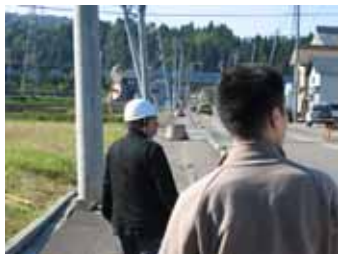
桜町周辺，小千谷市総合体育館近く 倒壊建物の前面道路のマンホールの浮上と電柱の傾斜，沈下
