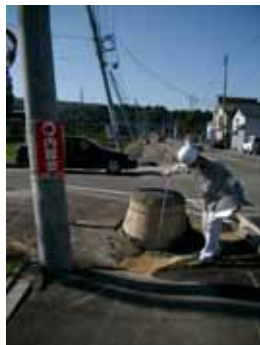
桜町周辺，小千谷市総合体育館近く 倒壊建物の前面道路のマンホールの浮上と電柱の傾斜，沈下
