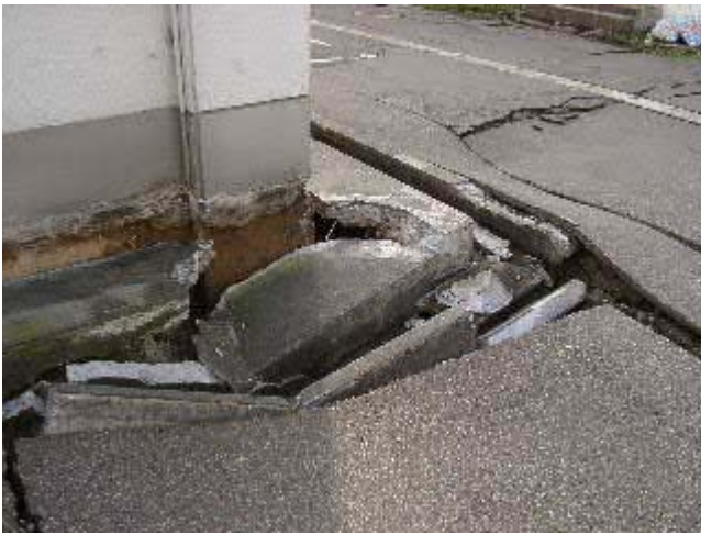
写真8 3号館の北西隅角部（斜面の際）
