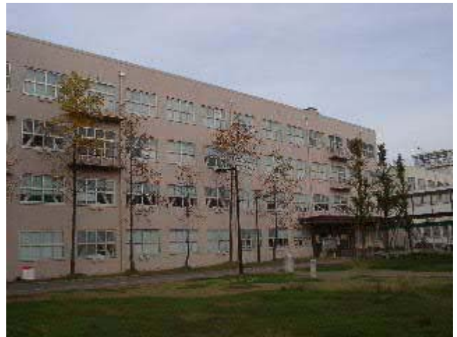
写真16 4号館(Kブレース補強)
