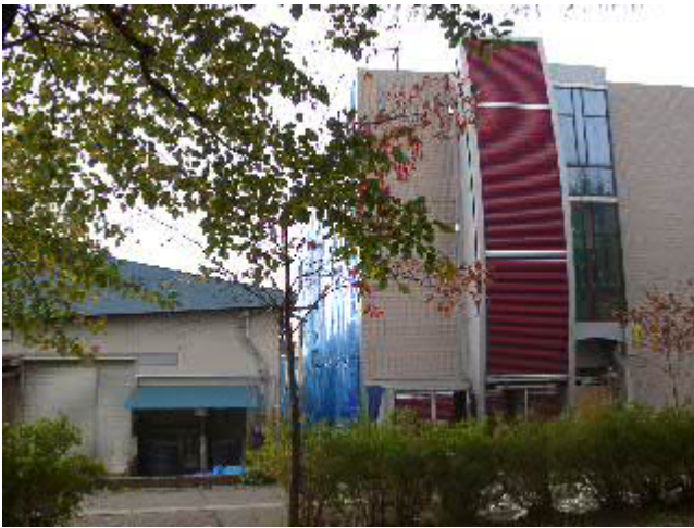
写真19 5号館（右）を南からみる。ブルーシートで覆われている）
