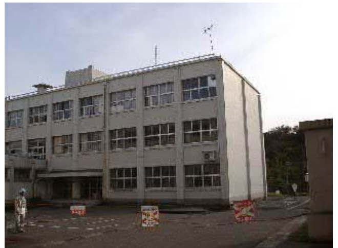
写真6 3号館（北東より）
