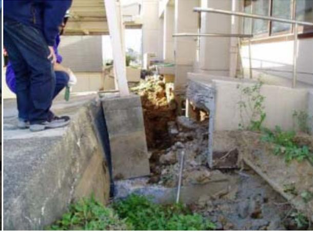
地滑り、地盤の陥没により露出した基礎
