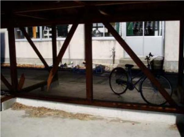
自転車置場の筋交破断
