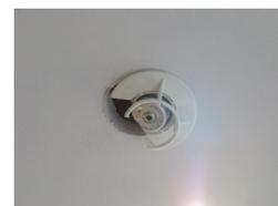
建築物Qは、2021年2月の地震では、天井や壁といった内装材の破損等に加え、設備系統の配管の破損による水漏れ、図書の落下等が発生した。2022年3月の地震では、内装材の破損や図書の落下等に加え、スプリンクラー配管の破損による水漏れや防火扉との接触によるスプリンクラーヘッドの損傷等が見られた。
