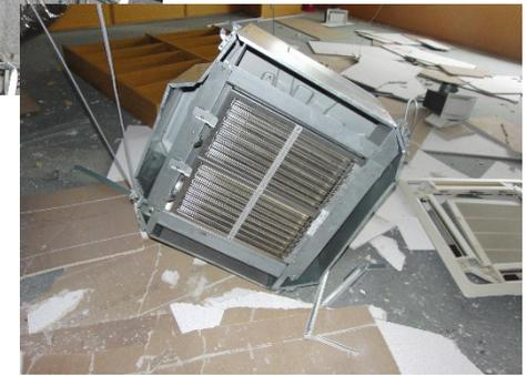
落下した天吊り機器と吊ボルトの状況
