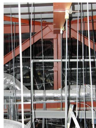
写真1-9 ハンガー脱落事例
