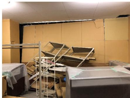
建築物Rは、2021年2月の地震において、エスカレータ周辺の床スラブの破損、Exp.J周辺の被害、天井や壁といった内装材の破損等が発生した。2022年3月の地震においても同様の被害が生じ、空調設備や防火扉の脱落、給水管の破損等が見られた。
