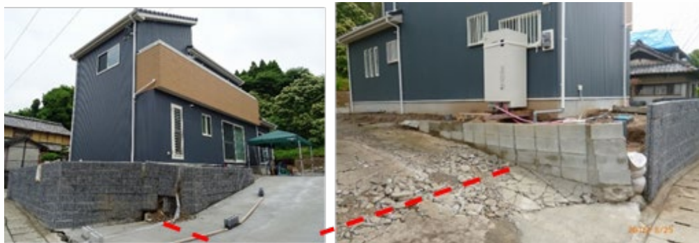
熊本地震横ずれ断層上木造住宅 べた基礎で現存
