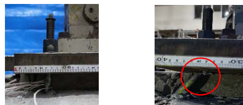
(f) アンカーボルトの傾き (g) アンカーボルト破断
