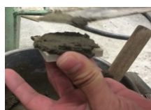
a) タイル裏モルタル
