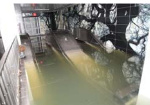
South Ferry 駅の浸水状況 出典: MTA Webサイト
