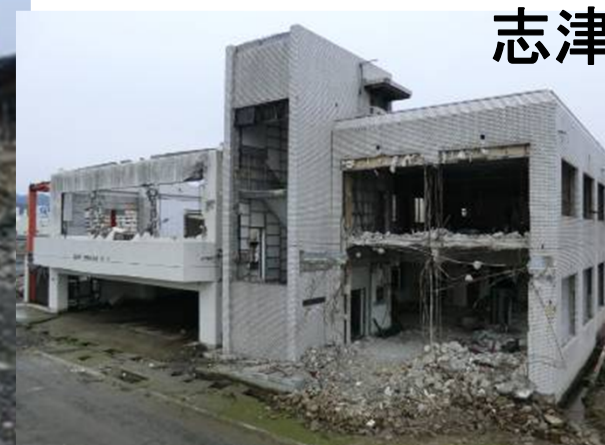
町営松原団地(2005.10、2006.3築) 屋上に44人(住民22人・近隣高校生) 翌日夕方まで孤立
