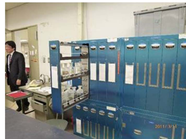
20階 薬品入れの引き出しが 飛び出し
