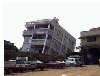
1999年台湾・集集地震による地表断層上のRC建物の傾斜
