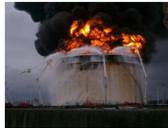
2003年十勝沖地震の苫小牧市におけるナフサタンクの全面火災
