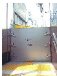
止水板設置時の出入口 (横浜市交通局)
