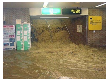
博多駅地下街の浸水 (1999.6.29)
