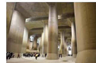
世界最大級の 地下放水路: 首都圏外郭 放水路 「地下宮殿」 (工事費 約2300億円)
