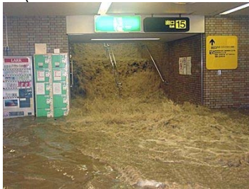
博多駅地下街の浸水 (1999.6.29)
