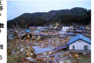
岩手県釜石市鶴住居地区
