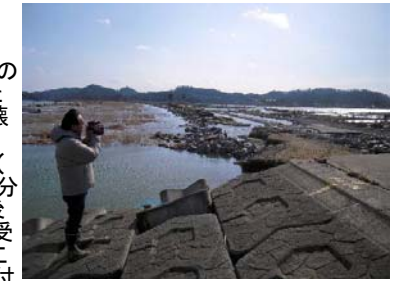
破壊された防潮堤(宮城県東松島市)
