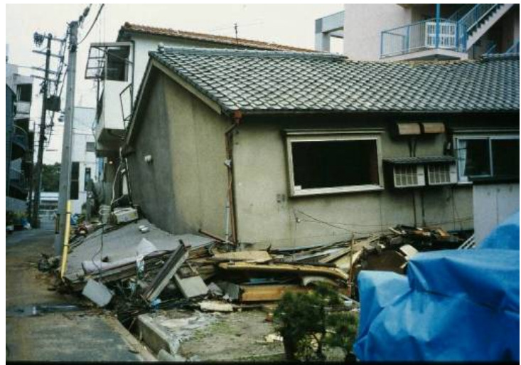
図5 1階の壁不足による木造家屋の被害
