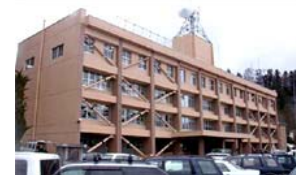
耐震補強の例
