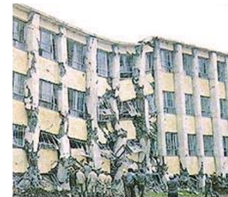
1968年十勝沖地震 (RC造短柱被害など)
