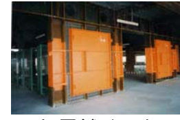
制震補強の例
