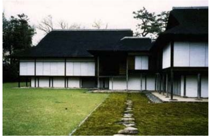
高床(ピロティー)による水害対策
