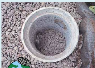
雨水浸透ます (直径15～50cm程度)
