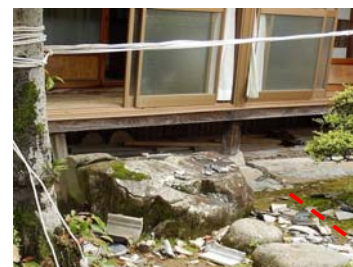
地表地震断層と束基礎・柱のずれ(南面)
