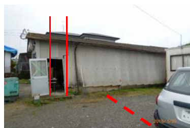
地表地震断層と傾斜した鉄骨造工場
