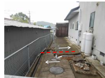
北側は約1.5mの盛土と地表断層のずれ(布基礎・耐震壁で基礎・建物は変形せず)
