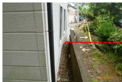
地表地震断層と同建物の傾斜被害(南面)
