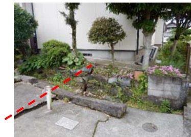
地表地震断層による段差(建物東面)
