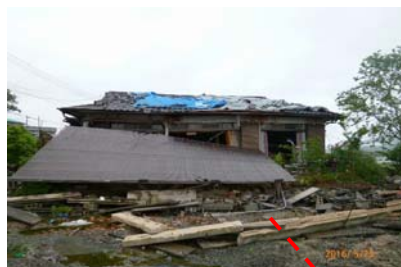
建物南面の被害(壁量の不足)
