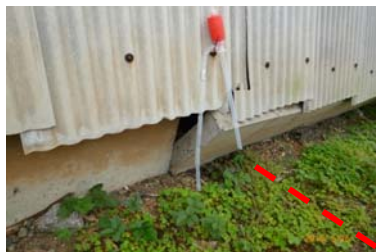
無補強コンクリートブロックの被害
