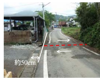
正面道路の地表地震断層(約50cmのずれ)
