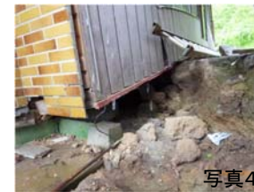
2011年福島県浜通り地震の地表地震断層の近傍における建物被害調査(久田ほか、2012)
