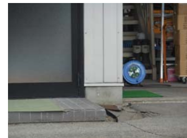
建物柱脚部の地盤亀裂(基礎は無被害)
