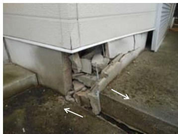
断層ずれと無筋コンクリートブロックの被害
