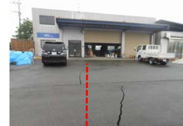
建物北面の敷地の亀裂(建物が外観上無被害)
