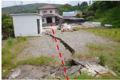
地表地震断層による段差(建物西面)
