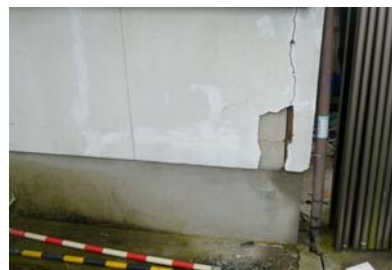
べた基礎と柱接合部の被害
