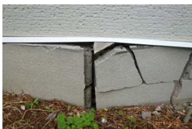
無筋コンクリートブロック基礎の被害
