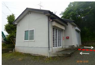
地表地震断層と古い在来木造住宅の被害
