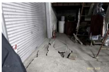
建物内の被害の様子(無筋の土間コンの被害、基礎の破壊により躯体構造も変形)
