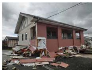
写真 3.3-6 倒壊した木造住宅
