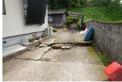
地表地震断層による敷地段差(西面)
