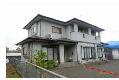
新しい軽量鉄骨造(南面、外観上無被害)
