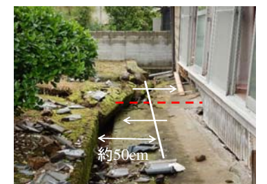
断層のずれによる建物変形(北面)
