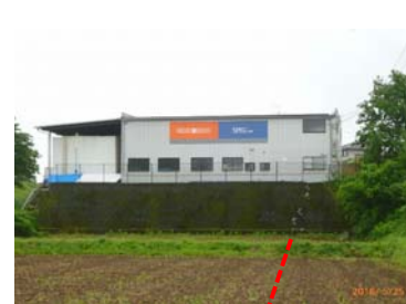
敷地北面の盛土擁壁の亀裂
