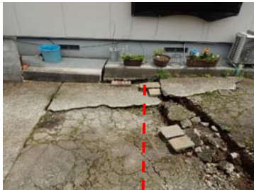
基礎の亀裂(西面:べた基礎等で被害軽微)
