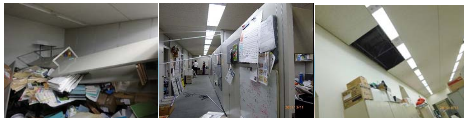
24F(固定していないかった本棚の転倒、間仕切り壁の大変形)
