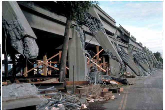
写真 1 Marina District の木造アパートの被害（左：1 階のせん断耐力不足）と Interstate Highway 880 の高架橋の被害（右：支持柱の耐力不足） http://pubs.usgs.gov/dds/dds-29/
