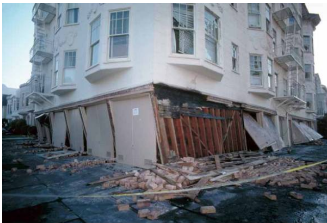
写真 1 Marina District の木造アパートの被害（左：1 階のせん断耐力不足）と Interstate Highway 880 の高架橋の被害（右：支持柱の耐力不足） http://pubs.usgs.gov/dds/dds-29/
