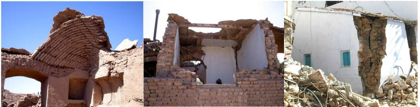
(a) アドベの地震被害(イラン・バム市) (b) レンガ造建物の被害(同バム市) (c) 石積建物の被害(インド・ブジ市)
