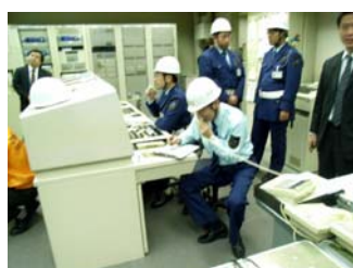
防災センター・警備室
