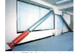
制振補強の例
