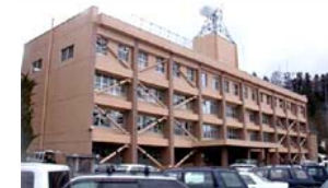
耐震補強の例
