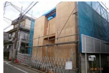
構造計算を実施。1階を壁の多い居室、2階をリビングとし、部材を金物・筋違等で固定。さらに構造合板をバランスよく配置し、耐震等級3(基準法の1.5倍の耐力)とした
