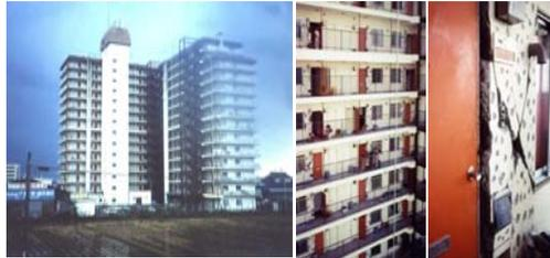
高層マンションの被害(ほぼ全戸で非構造壁が、せん断破壊し玄関ドアが開かなくなった)→補修したが、東日本大震災でさらに大きな被害、取り壊しに...
