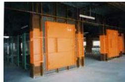
制振補強の例
