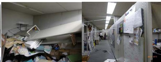
24F(本棚の転倒、間仕切り壁の大変形)
