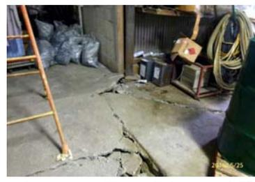
建物内の被害の様子(無筋の土間コンの被害、基礎の破壊により躯体構造も変形)
