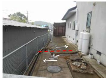
北側は約1.5mの盛土と地表断層のずれ (べた基礎・耐震壁で基礎・建物は変形せず)
