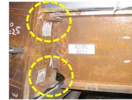
梁端フランジの破断
