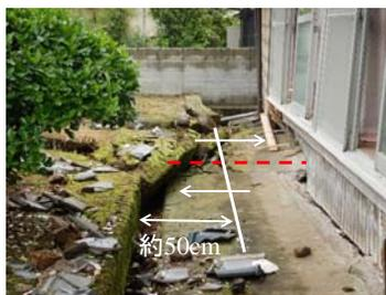
断層のずれによる建物変形(北面)
