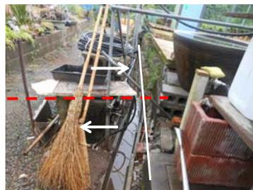
建物北面庭の地表地震断層によるずれ変形 建物室内(べた基礎であり、ほぼ無被害)
