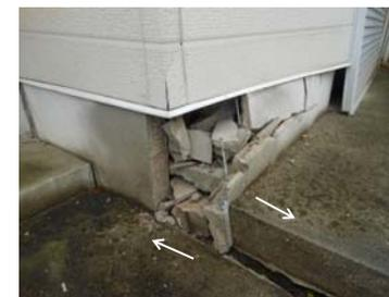
断層ずれと無筋コンクリートブロックの被害
