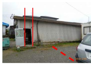
地表地震断層と傾斜した鉄骨造工場
