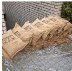
土嚢による止水
