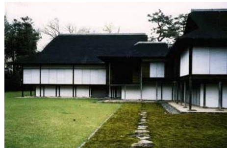
高床(ピロティー)による水害対策
