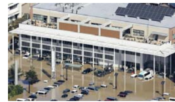
「防災＝耐震」だった常総市役所 東北関東集中豪雨(2015年9月10日)
