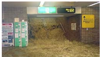
1999年福岡市博多駅地下街の浸水 ⇒ 水防法改正（止水・避難計画が必須）
