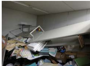
24F (固定していないかった本棚の転倒、間仕切り壁の大変形)
