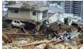
広島市の土砂災害（2014年）
