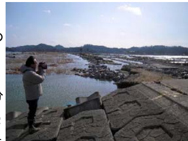
破壊された防潮堤(宮城県東松島市)
