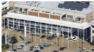
「防災＝耐震」だった常総市役所 東北関東集中豪雨（2015年9月10日）
