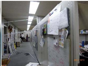
24F (固定していないかった本棚の転倒、間仕切り壁の大変形)
