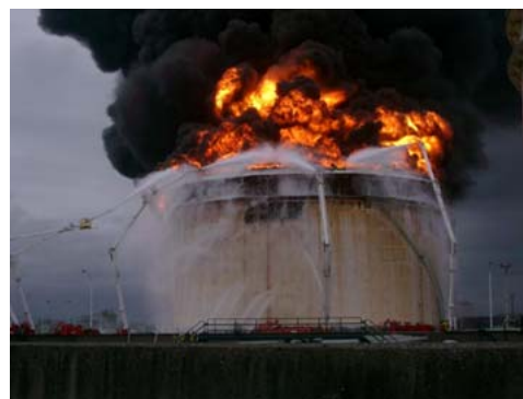
図 29 2003 年十勝沖地震の苫小牧市における浮屋根が沈没したナフサタンクにおいて、地震の 2 日後に発生したタンク全面火災 (消防庁提供: http://www.fri.go.jp/bosai/tokachi_lpgn.html )
