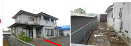
②新しい住宅(軽量S?, RCべた基礎)、D1(軽微)
