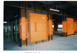
制震補強の例
