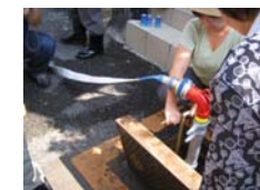
消火栓とスタンドパイプ
