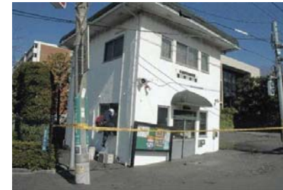
液状化(浦安市)
