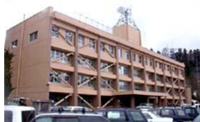
耐震補強の例
