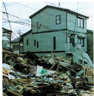
（阪神大震災全記録、毎日ムックより）
