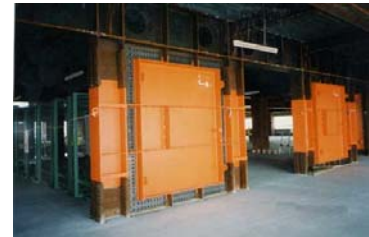
制震補強の例
