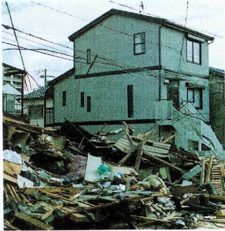
(阪神大震災全記録、毎日ムックより)
