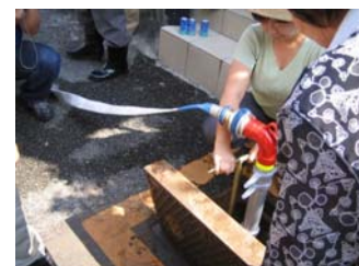
消火栓とスタンドパイプ
