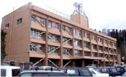
耐震補強の例
