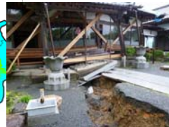
2011年福島県浜通り地震による被害（建徳寺）
