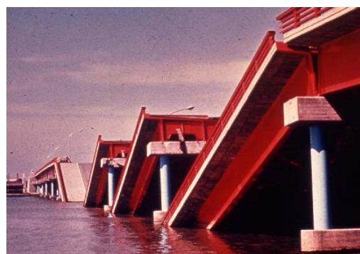
図 30 1964 年新潟地震の液状化による被害 (左: 川岸町アパートの倒壊、右: 昭和大橋の落橋) (左: http://www.city.yokohama.jp/me/bousai/ekijouka_map/q&a.html 、 右: http://homepage2.nifty.com/yoshimi-y/niigata1.htm )
