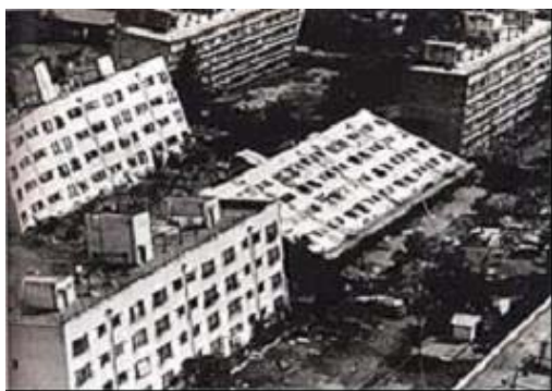
図 30 1964 年新潟地震の液状化による被害 (左: 川岸町アパートの倒壊、右: 昭和大橋の落橋) (左: http://www.city.yokohama.jp/me/bousai/ekijouka_map/q&a.html 、 右: http://homepage2.nifty.com/yoshimi-y/niigata1.htm )
