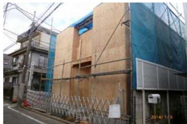
構造計算を実施。1階を壁の多い居室、2階をリビングとし、部材を金物・筋違等で固定しさらに構造合板をバランスよく配置し、耐震等級3(基準法の1.5倍の耐力)とした
