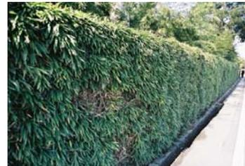
**桂垣**：生垣の一つ。桂離宮に造られているためこの名がある。自生の竹を用いた垣で、30cm間隔に1本ずつ垣の高さよりさらに突き出させ、45°に外方へ折り曲げて横木に取り付けたもの。
