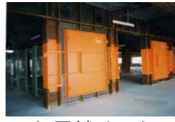
制震補強の例
