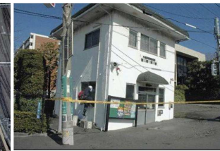
液状化被害(浦安市)
