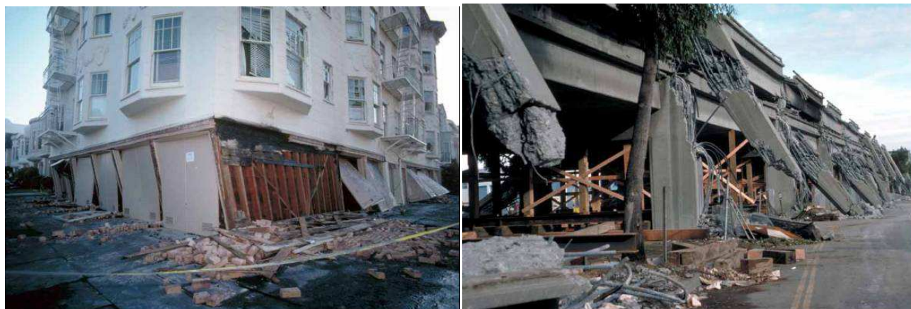
写真 1 Marina District の木造アパートの被害（左：1 階のせん断耐力不足）と Interstate Highway 880 の高架橋の被害（右：支持柱の耐力不足） http://pubs.usgs.gov/dds/dds-29/
