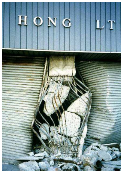
図6 旧基準のRC造建物の柱のせん断破壊（左）と中間層破壊（上）
