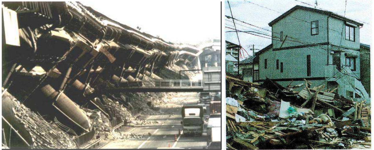
図4 倒壊した阪神高速神戸線（左： http://www.hp1039.jishin.go.jp/eqchr/eqchrfrm.htm ）、倒壊した木造家屋（手前）と無被害な家屋（右：阪神大震災全記録、毎日ムックより）
