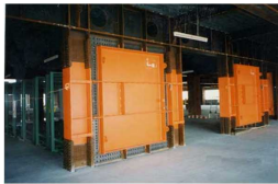
制震補強の例
