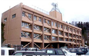
耐震補強の例
