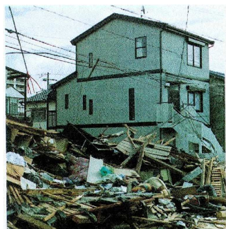
（阪神大震災全記録、毎日ムックより）
