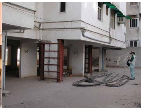
(d) 一階の柱が細長い断面の高層マンション（インド・アーメダバード）
