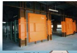
制震補強の例
