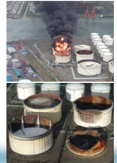
苫小牧の石油タンクの被害
