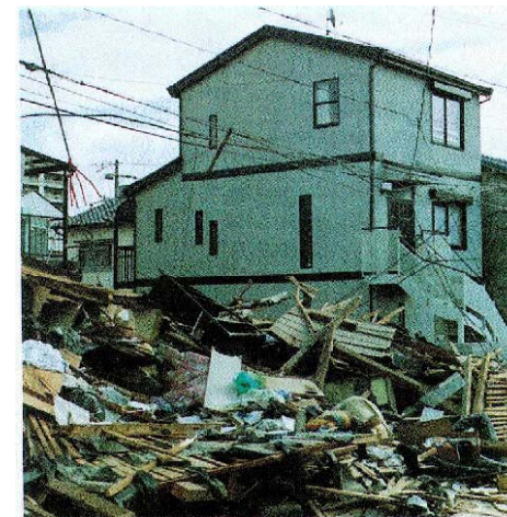
(阪神大震災全記録、毎日ムックより)
