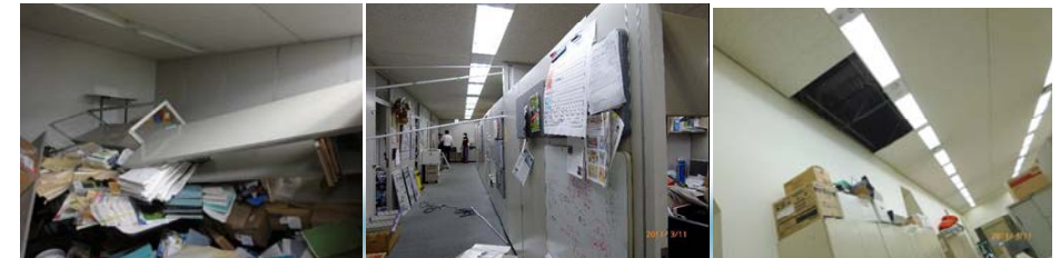
24F(固定していないかった本棚の転倒、間仕切り壁の大変形)
