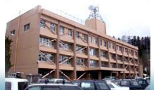
耐震補強の例
