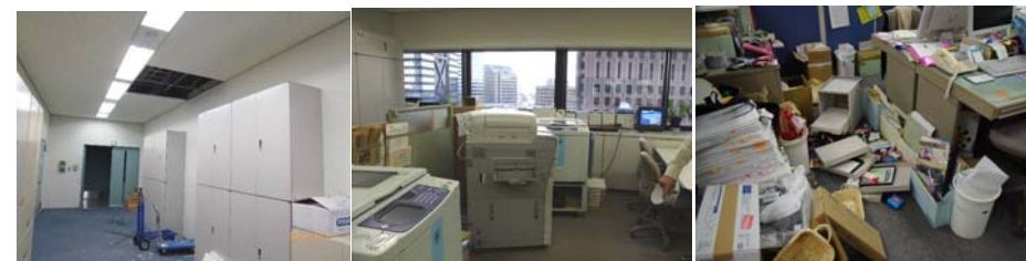
14F (天井パネルの落下)
