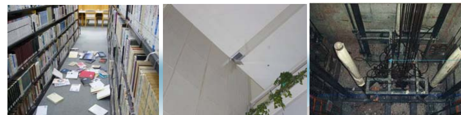
2F (図書館:蔵書の散乱) 1F (アトリウム:EPJパネルの被害) エレベーターケーブルの絡まり (本学の写真ではありません)
