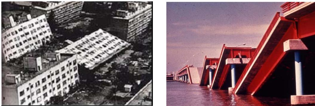
図 30 1964 年新潟地震の液状化による被害 (左: 川岸町アパートの倒壊、右: 昭和大橋の落橋)
