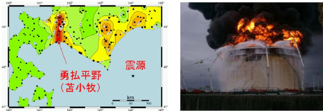
図 29 2003 年十勝沖地震の苦小牧市における浮屋根が沈没したナフサタンクにおいて、地震の 2 日後に発生したタンク全面火災 (消防庁提供: [http://www.fri.go.jp/bosai/tokachi\\_lpgn.html](http://www.fri.go.jp/bosai/tokachi_lpgn.html))
