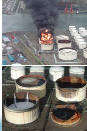
苫小牧の石油タンクの被害
