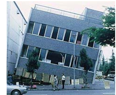
1968年十勝沖地震(RC造被害) 1978年宮城県沖地震(ピロティ被害)
