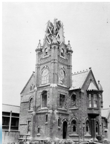
レンガ建築や煙突(組石建築)の被害
